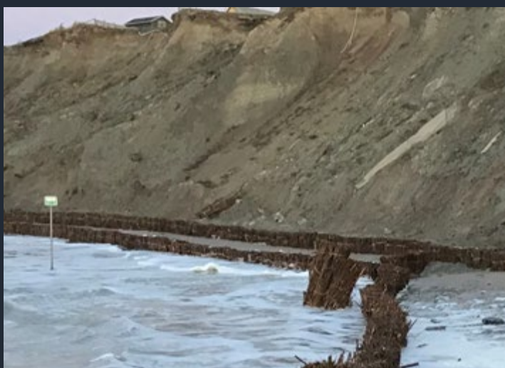
Nyletablerad anläggning. Pilbuntar är monterade 70 cm över marknivån.
