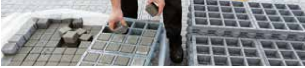
Isättning av gatstenar i TTE®-elementet
