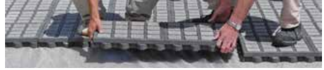
Läggning av de fyllda TTE®-elementen i par
